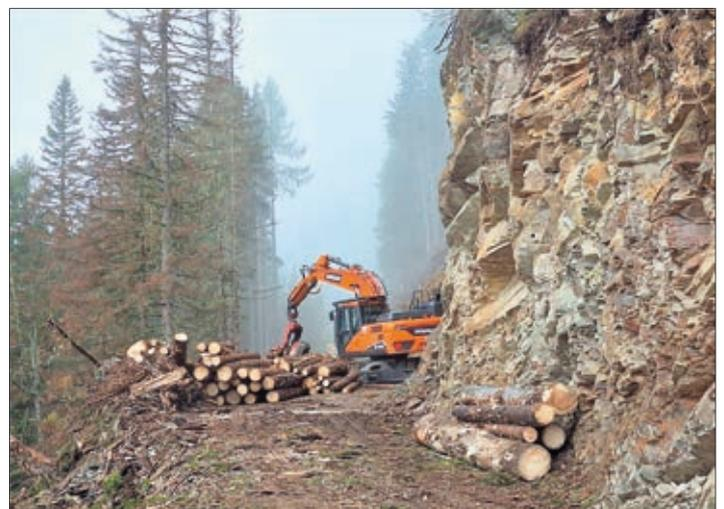
Senkrechte Böschung mit ca. 9 m Höhe. Direkt im Anschluss an Wegbau – Baggerprozessor bei Trassen- und Schadholzaufarbeitung.
