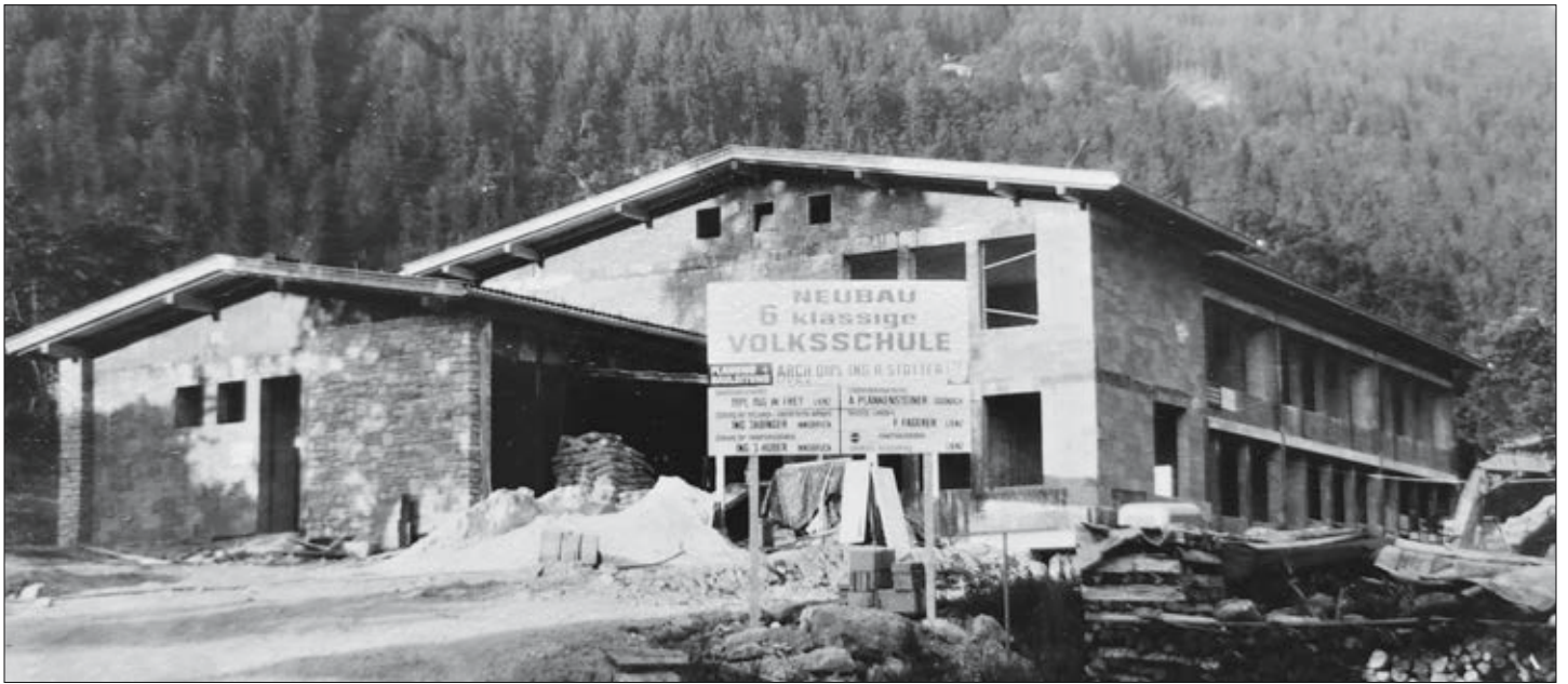
Der Rohbau zeigt die stolzen Ausmaße.
