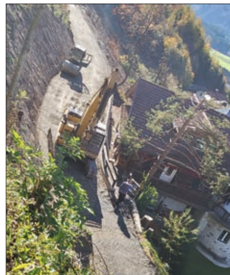
Bau Hofzufahrt Ranitzer.
