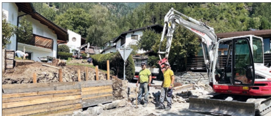
Für eine bessere Übersicht wurde hier gearbeitet. Am Foto Karl und Thomas Plautz.
