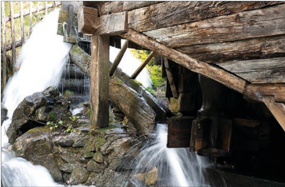
Stockmühle in Kals – der Wasserzulauf auf die Turbine kann mit der Wasser-Regulierungsstange eingestellt werden.
