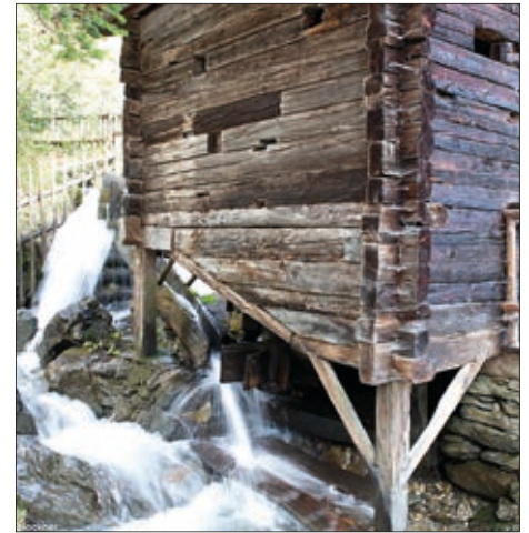
Stockmühle in Kals – der Wasserzulauf auf die Turbine kann mit der Wasser-Regulierungsstange eingestellt werden.
