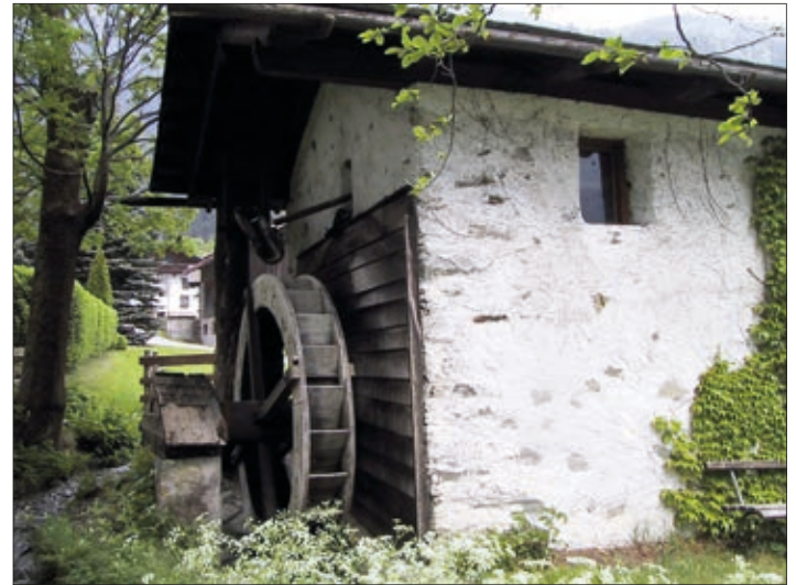
Die Bachler Mühle (l.) und die Stockele Mühle sind die zwei letzten Radmühlen, die noch in Nikolsdorf erhalten sind. Die Bachler Mühle ist voll funktionsfähig, bei der Stockele Mühle fehlt der Wasserzufluss, um sie zu betreiben.
